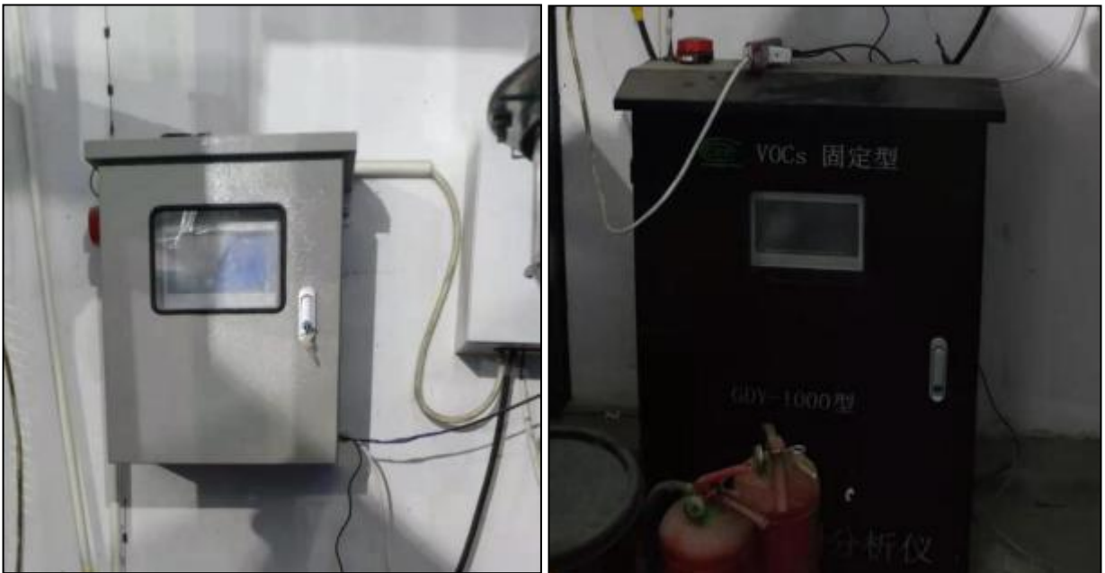
图 4-3 粉尘在线监测仪和 VOCs 在线监测超标报警装置
